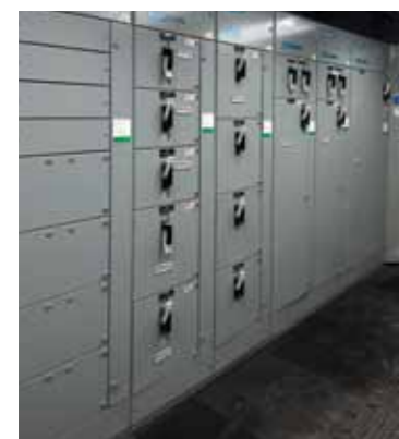
Силовые панели поставляются смонтированными на нижнем уровне будки управления.
